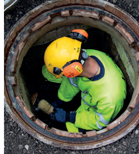
^ Lavori nel pozzetto d'ispezione: lo spazio è limitato.
