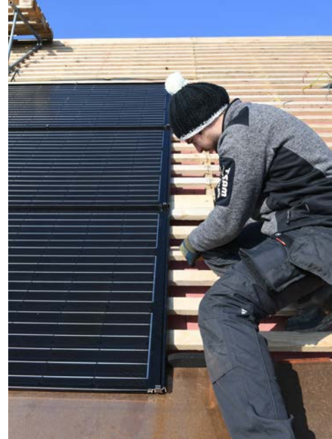
^ Vitor monta pannelli solari direttamente sopra la struttura portante del tetto.
