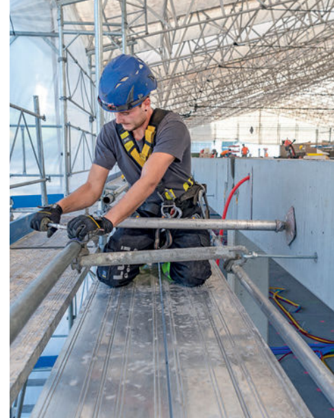
Manuel regola la distanza dell'impalcatura dalla parete.
