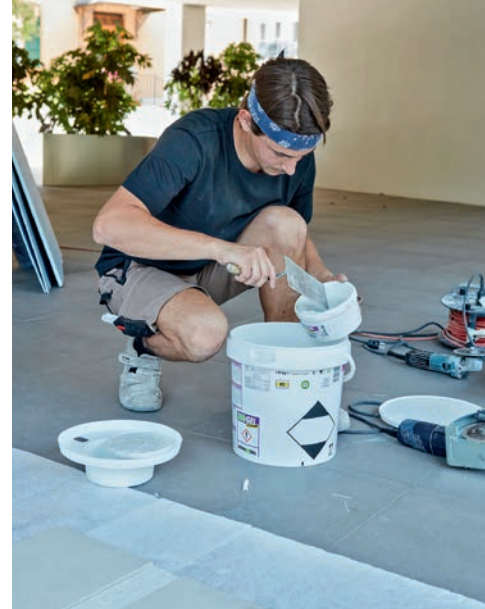
Prima di applicarla sul pavimento, Nicolò Brivio mescola la colla con l'acqua.
