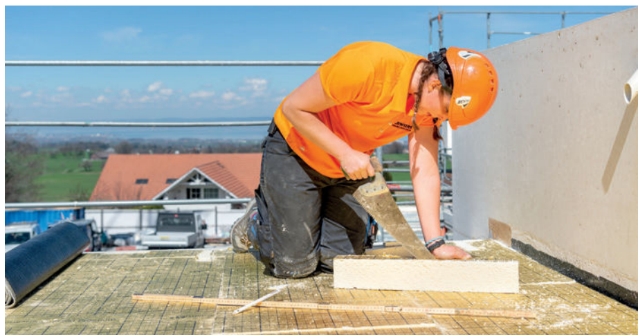
▶ Prima di procedere all'impermeabilizzazione, Svenja taglia e posa il materiale isolante.
