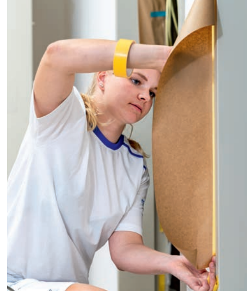
^ Prima di verniciare i telai delle porte, Susan protegge con appositi materiali le pareti adiacenti.
