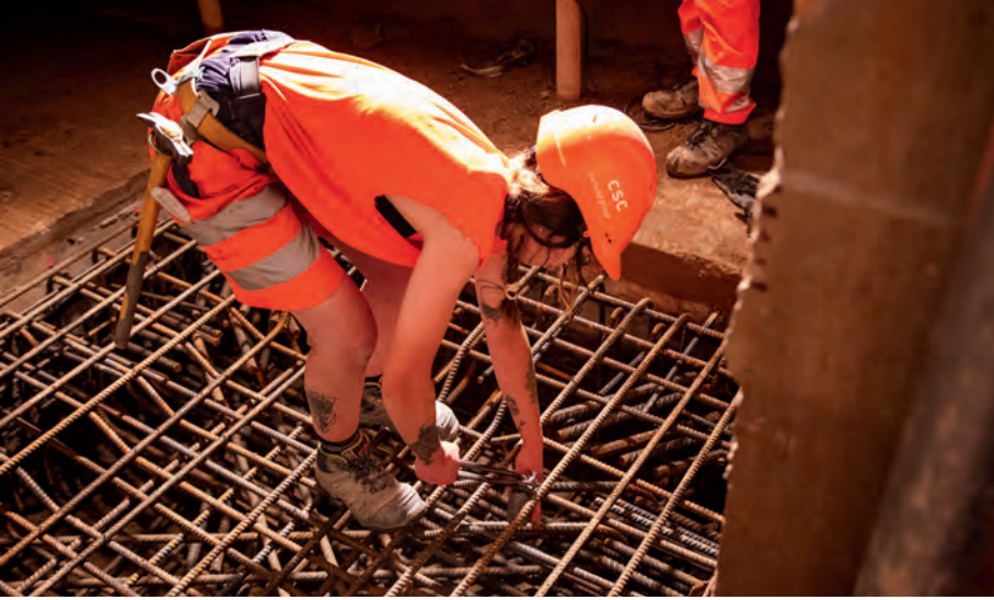
◀ L'armature métallique est posée et attachée avant le coulage du béton.
