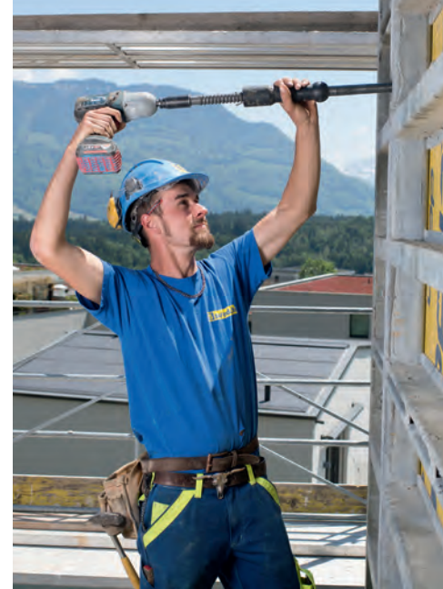
^ Des éléments préfabriqués en métal servent aussi pour les coffrages.
