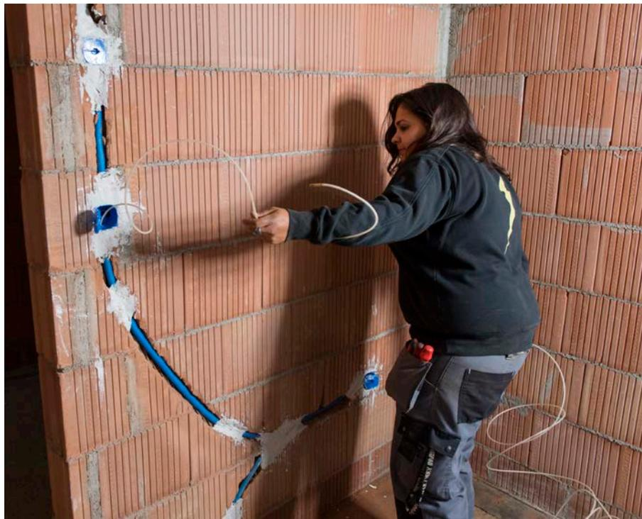
plus qu'à fixer les prises ou les interrupteurs, et à raccorder les câbles au tableau électrique. »L'un de nos installateurs-électriciens inspecte toujours une première fois les installations, afin de vérifier que les câbles sont bien isolés ou encore que le tableau électrique est correctement étiqueté (circuit cuisine, circuit salon, etc.). Il s'agit aussi de mesurer la tension. Un conseiller en sécurité électrique est
