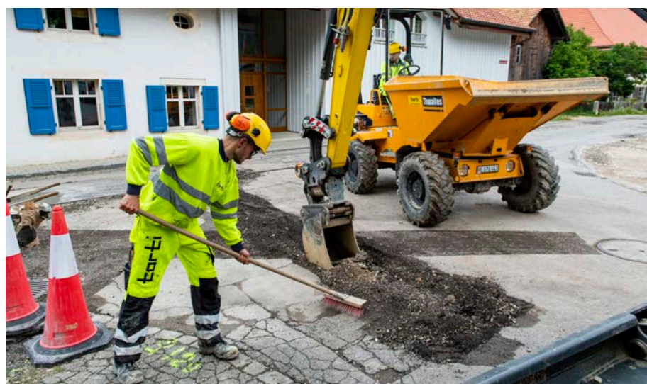
▲ Les réparations font aussi partie du quotidien des constructeurs de routes.
