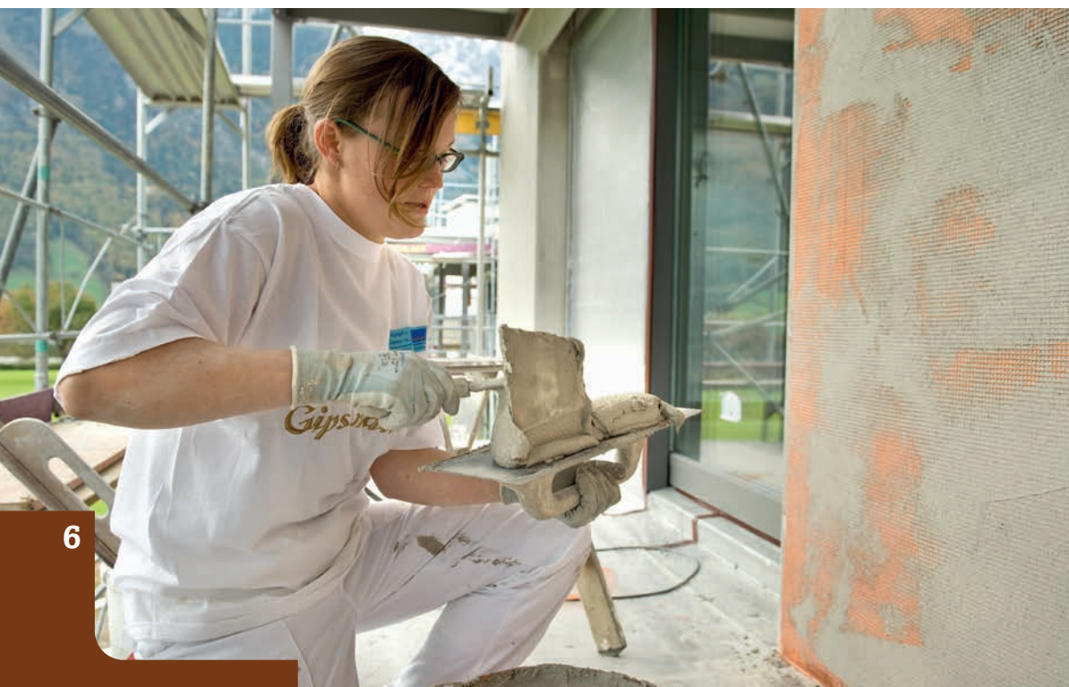
Plâtrière constructrice à sec CFC
