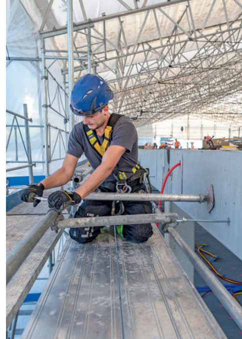
Manuel Hilbi corrige la distance entre l'échafaudage et le mur.
