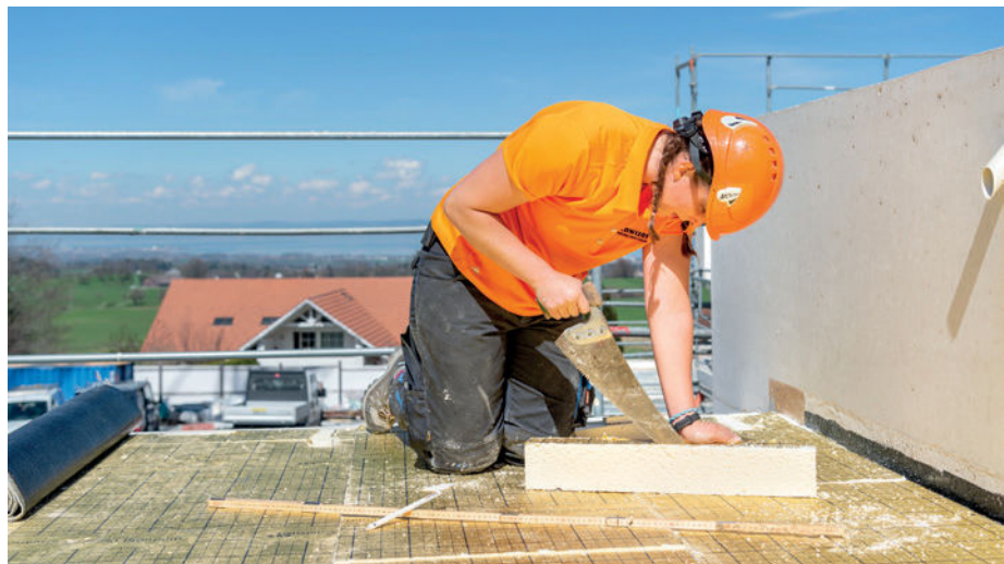
▲ Une fois découpé, l'isolant thermique est posé sur toute la surface du toit.
