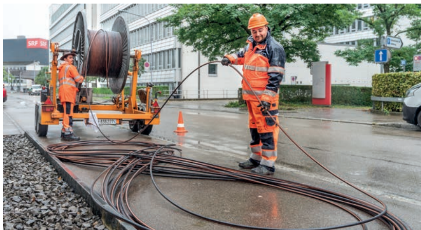
▲ Tomislav Vukovac enroule un câble de fibre optique en vue de son transport.
