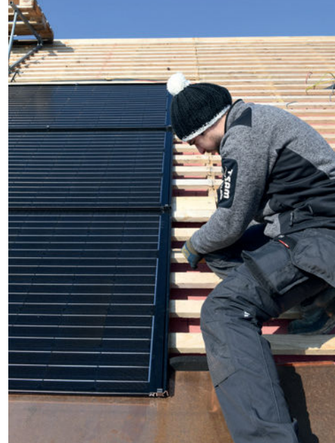
^ Vitor Magalhães monte les panneaux solaires directement sur la sous-construction.
