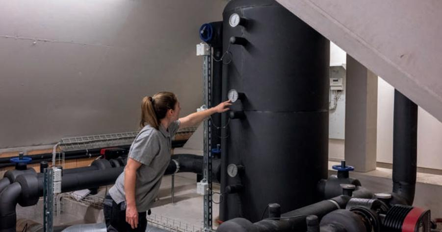
^ **Régler et contrôler les installations** Ces professionnels règlent les systèmes de chauffage, de ventilation et de climatisation et en vérifient régulièrement le bon fonctionnement.
