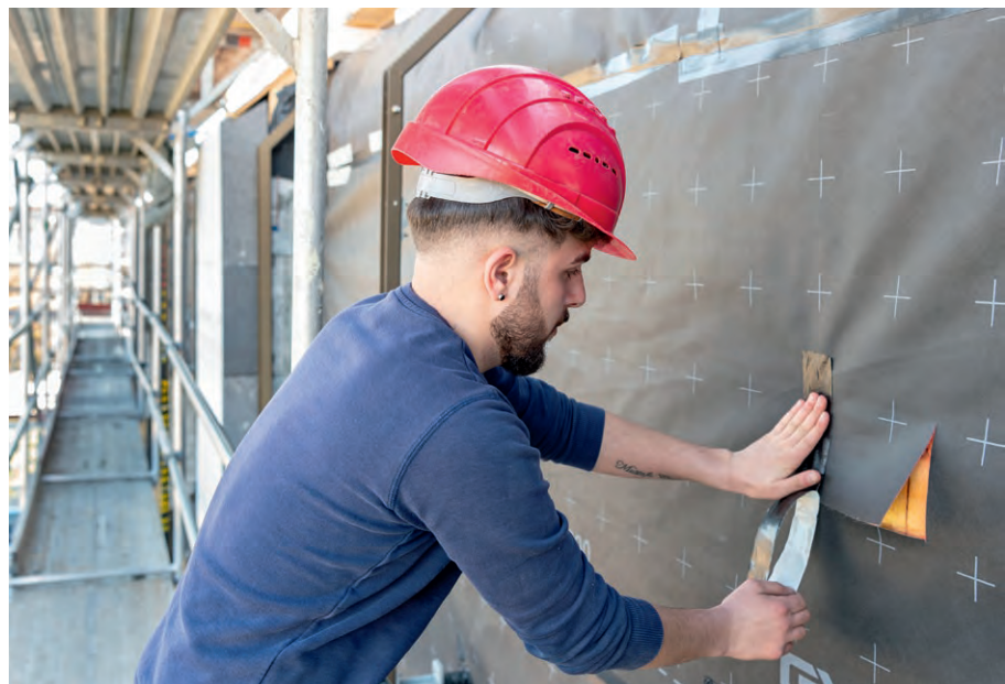
^ Mehmet Cek scotche le coupe-vent qui vient recouvrir l'isolant. Ces deux éléments jouent un rôle essentiel dans l'étanchéité et l'isolation d'un bâtiment.
