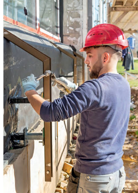
^ La sous-construction doit être montée minutieusement.
