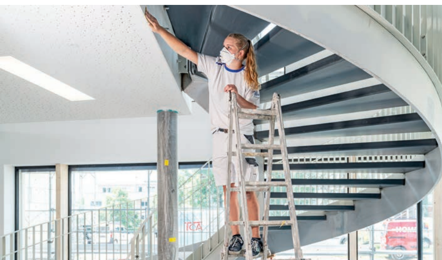
^ Les surfaces doivent être parfaitement poncées pour que la peinture adhère bien.
