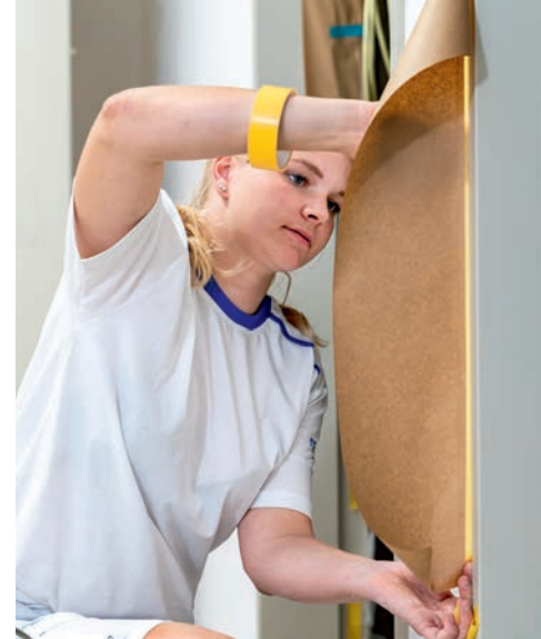
^ Avant de peindre les cadres de porte, Susan Wildermuth protège soigneusement les parois.
